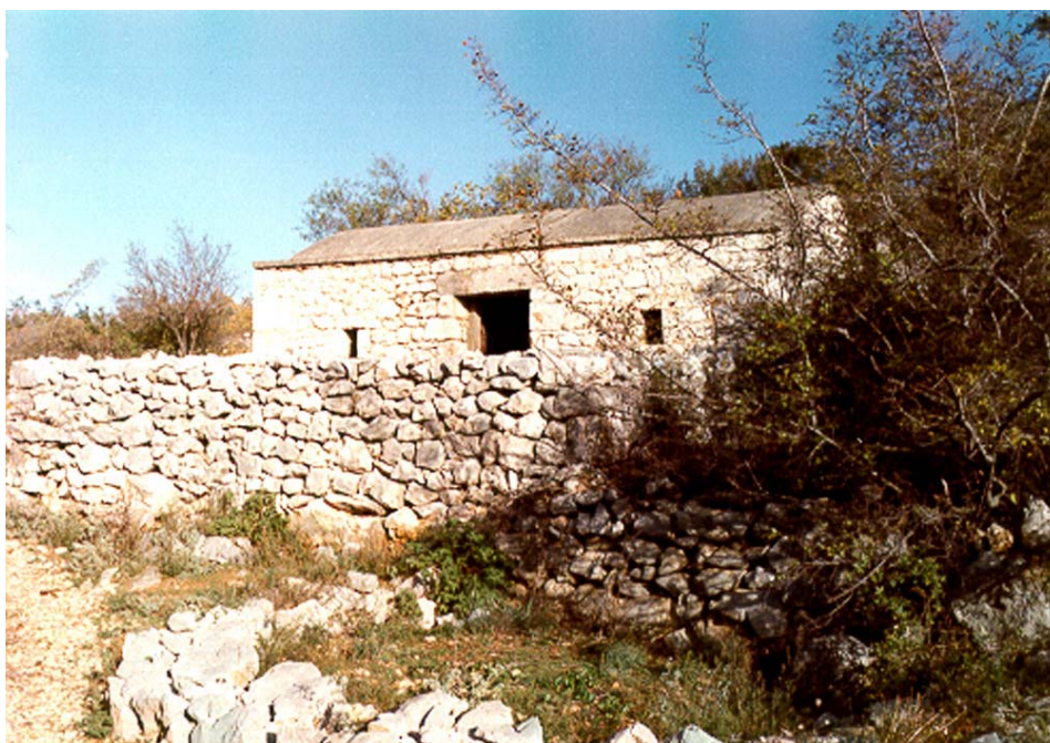
1.10. Stara kuća nekada korišćena za boravak ljudi i blaga u toku zime. Ograđena je visokim kamenim zidom koji vjekovima odoljeva iako je sagrađen običnim slaganjem kamena. Kamen je sakupljan iz obližnjih parcela koje su čišćenjem pretvorene u plodne njivice (vrtlove).
