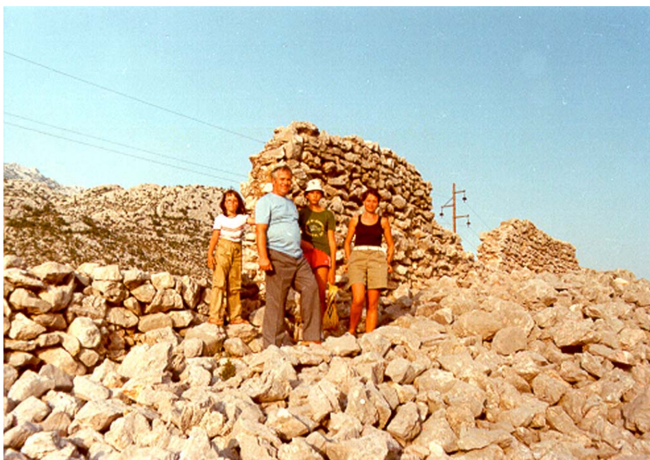
1.22. Ostaci zidina porušene Fortice.
