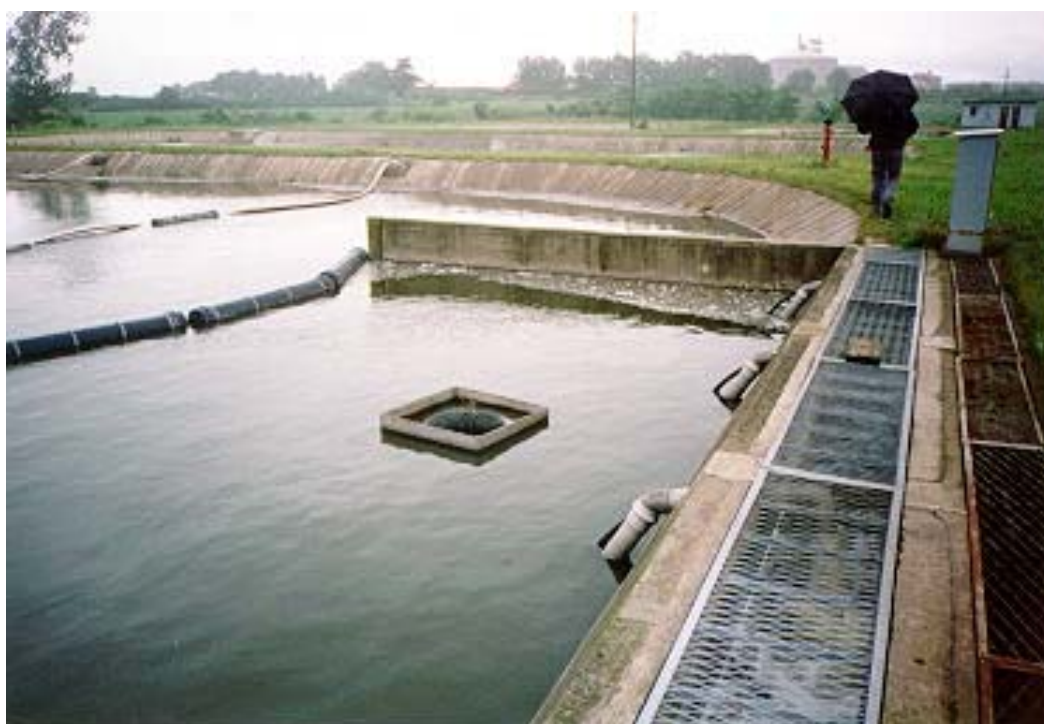
Slika 9 - Detalj sa postrojenja - Zona za evakuaciju mulja u laguni AL-I sa prelivnom šahtom za penu
