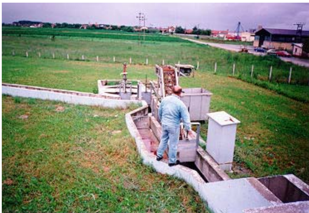
Slika 9 - Detalj sa postrojenja - Zona za evakuaciju mulja u laguni AL-I sa prelivnom šahtom za penu
