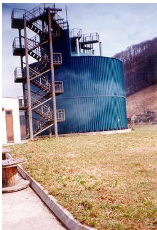
Slika 12 - Detalj sa postrojenja - Digestor za anaerono truljenje mulja
