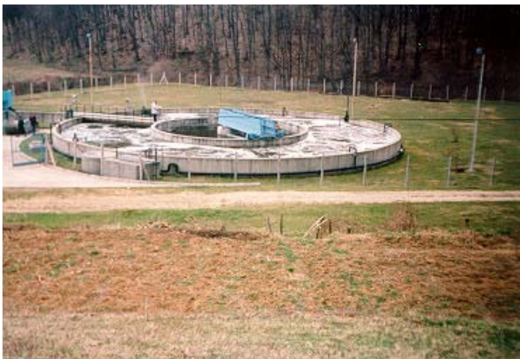
Slika 6 - Detalj sa postrojenja - Koaksijalni blok: biološki bazen - naknadni taložnik
