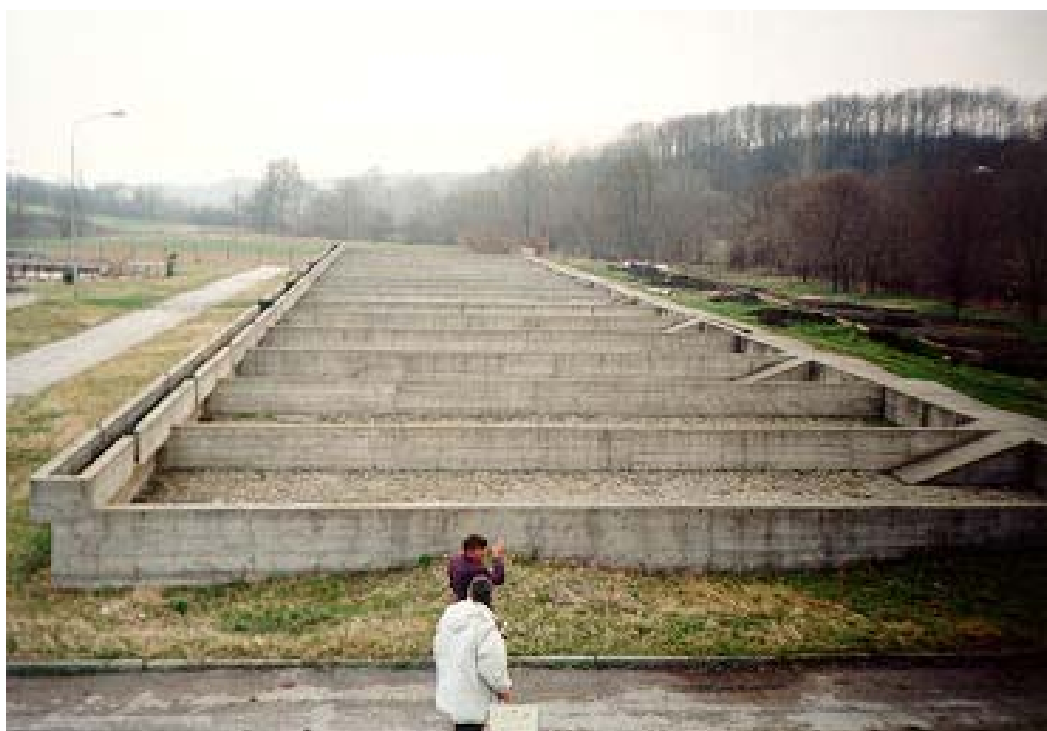
Slika 3 - Detalj sa postrojenja - Polja za sušenje mulja
