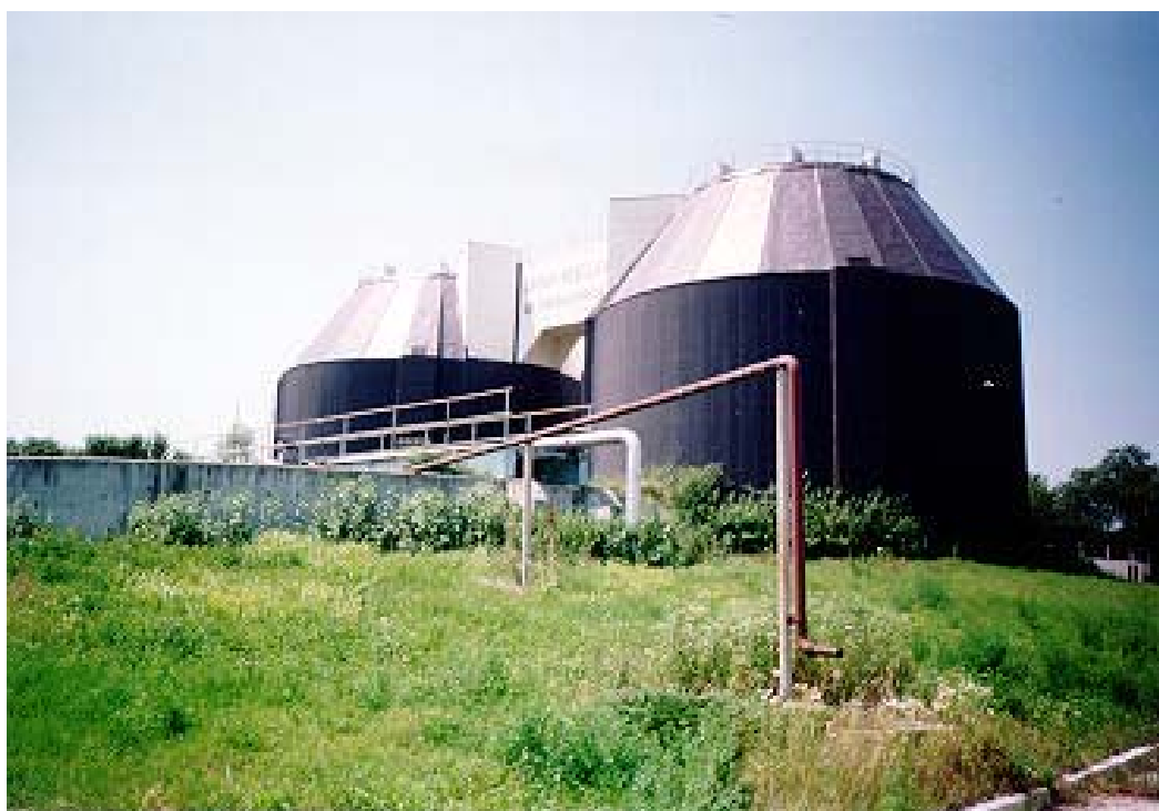
Slika 15 - Detalj sa postrojenja - Blok digestori za anaerobni tretman mulja
