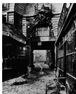
Slika 6 - Eugene Atgetova fotografija ulice Rue des Rennes iz 1900. godine, stari tip ulice bez izdignutog trotoara i sa rigolom za kanalizaciju postavljenom po sredini ulice
